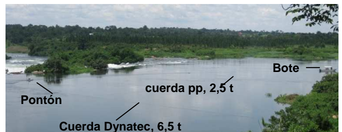
Imagen 4: Fijación del pontón contra la corriente
